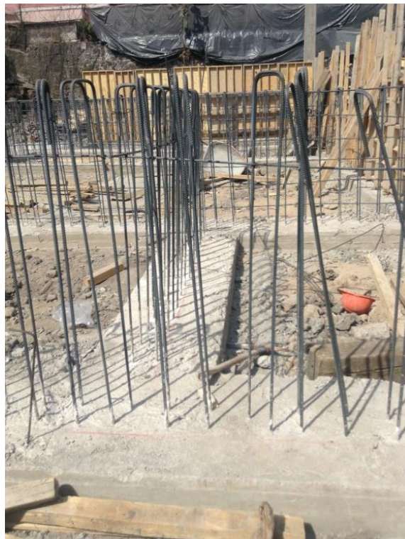
Foto 1. Armado de muro
