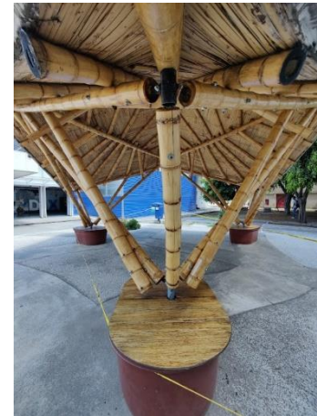
Fig. 6 Fotografía de estado final del mantenimiento de la palapa. Fuente: Oliver, I.
