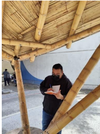
Fig. 2 Fotografía de inspección de palapa previo al mantenimiento. Fuente: Guzmán, M.
