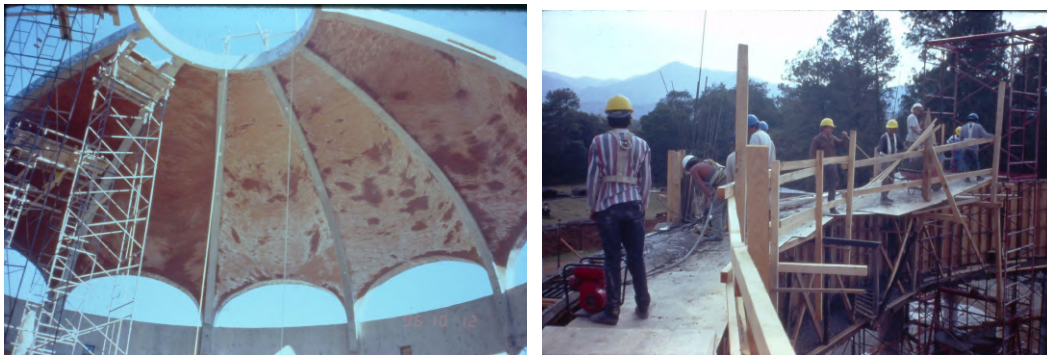
Procesos constructivos de obra, archivos recuperados de diapositivas.
