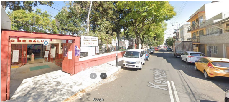
FIGURA 2. Exterior de C. S. T. III Ampliación Presidentes.
