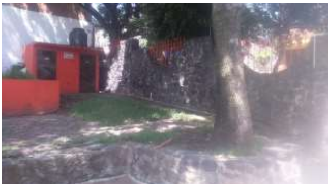
Estado actual de los baños
