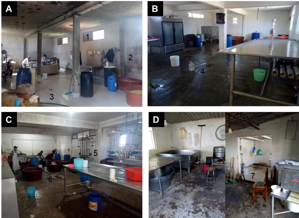
Figura 2. Instalaciones queserías evaluadas. A. Q1, no cuenta con ventilación, las ventanas están cubiertas con cartón (1), paredes con humedad y suciedad (2), piso de fácil limpieza con drenaje (3). B. Q2, cuenta con sistema de drenaje (4). C. Q3, cuenta con paredes de loseta de fácil limpieza (5), piso desgastado con acumulación de suero (6). D. Q4, no cuenta con sistema de drenaje (7).
