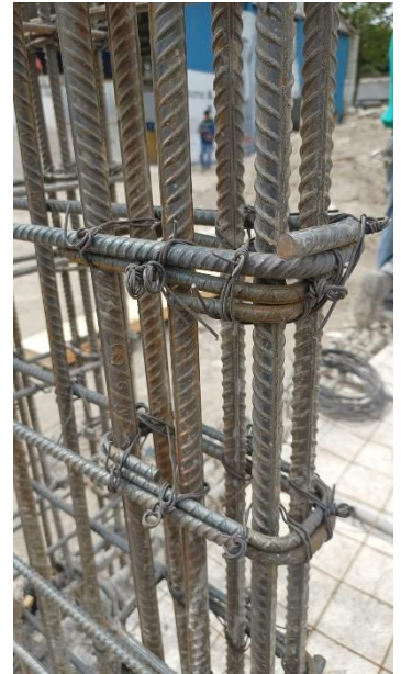
Imagen 3. Amarres en varillas. U.H Leyes de Reforma. 30 de enero del 2024. (Autoría propia).
