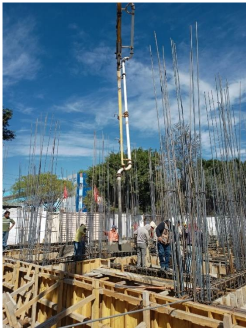
Imagen 4. Colado de Cimentación. U.H Leyes de Reforma. 25 de enero del 2024. (Autoría propia).
