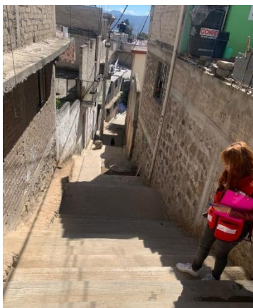
Imagen 5. Supervisión de trabajos de Rehabilitación de Andador Cedros de La Magdalena Contreras. Autoría Propia
