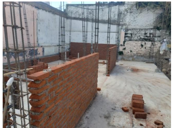
Imagen 4. Supervisión de trabajos de construcción de muros en el proyecto Red de Transporte Públicos de La Magdalena Contreras. Autoría Propia
