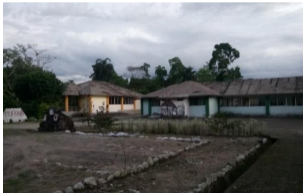
Figura 58. Centro comunitario de medicina tradicional y partería Amupakín. Fuente: Propia, 2022.
