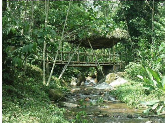
Figura 29. Obras para La ruta del cacao. Fuente: Propia, 2017.
