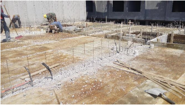
14. Preparando el encofrado e instalación que llevará la losa.
