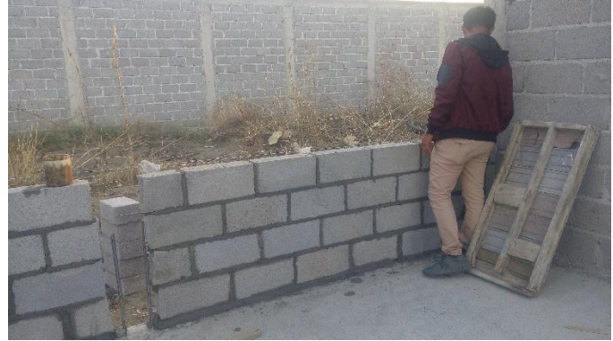
2. Visitando obra y revisando que la barda esté plomada
