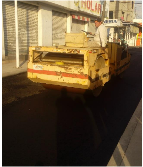
6. Máquina aplanadora, pasando sobre el asfalto recién vertido.
