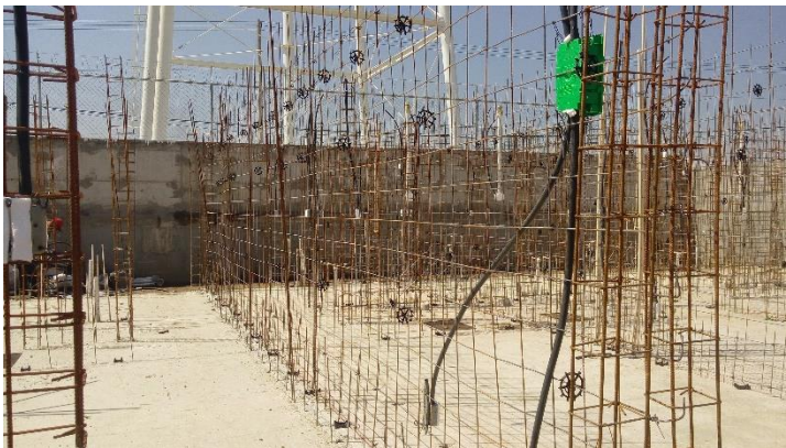
8. Levantamiento de muros con varillas prefabricadas y colocación de instalaciones, en obra supervisada por el arquitecto.
