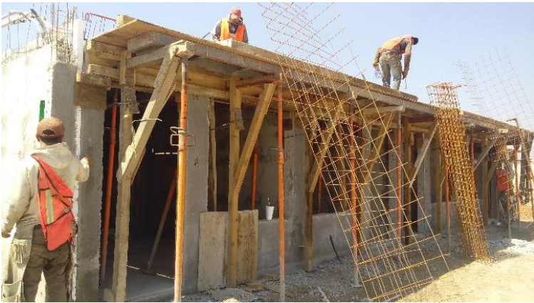
15. Colocación de puntales metálicos, encofrado e instalaciones de una losa.
