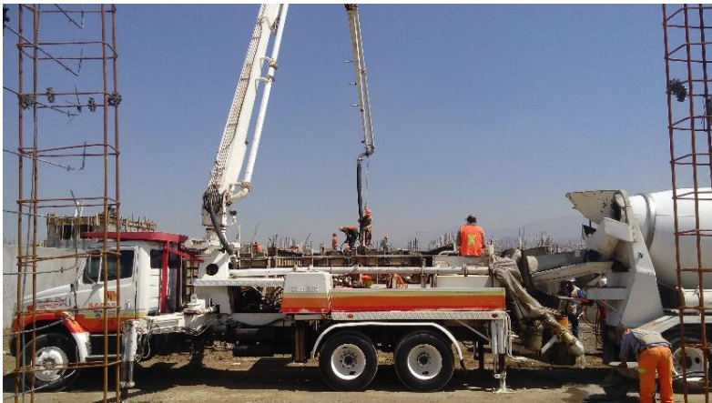
12. Vaciado con Bombas de concreto a las columnas y muros.
