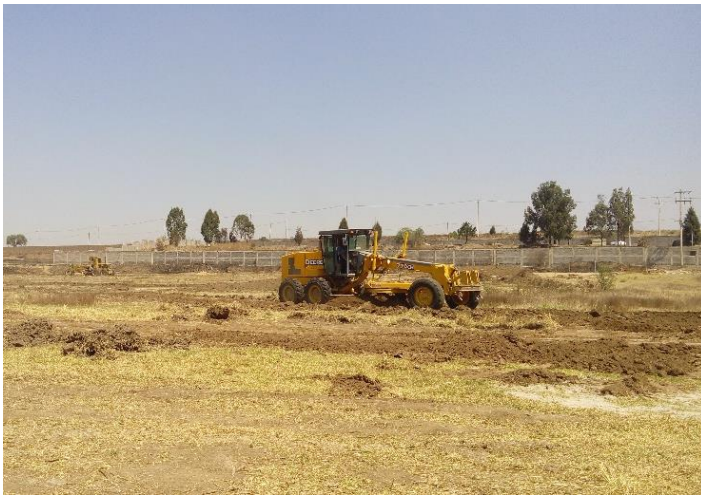
7. Motoniveladora nivelando y aplanando terreno en San Martin Cuautlalpan, EDOMEX.
