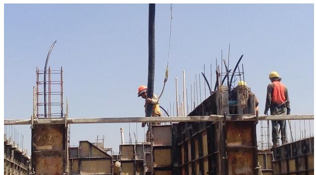
13. Vibrado y vaciado de concreto en obra.
