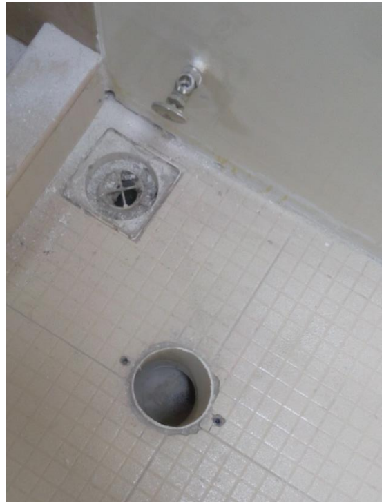
9. revisión de tubo de desagüe de un W.C.
