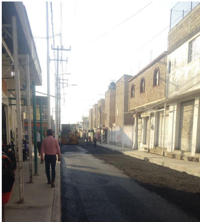
3. Supervisando la pavimentación de calles en Chalco.
