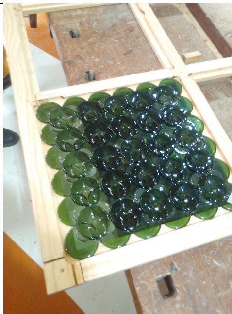
Fotografía 5: Verificando que los paneles de vidrio encajen en el marco Fotografía: Héctor Bravo López.
