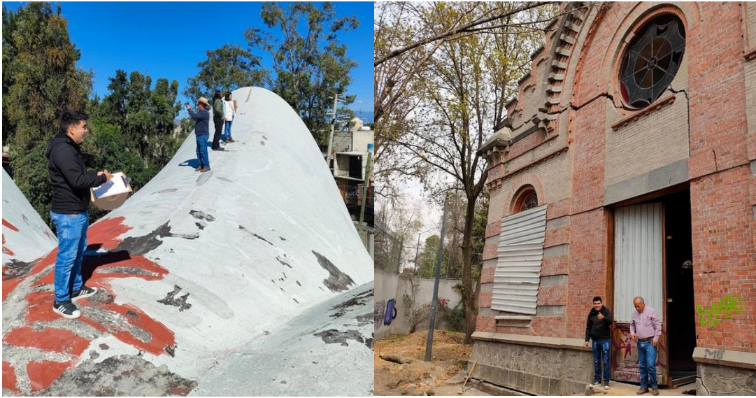
OBRA (RESTAURANTE MANANTIALES Y CASA DE BOMBAS) IMAGENES DE ARCHIVO PERSONAL AÑO 2024
