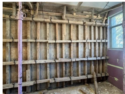
Ilustración 6 Cimbrado de muro de concreto
