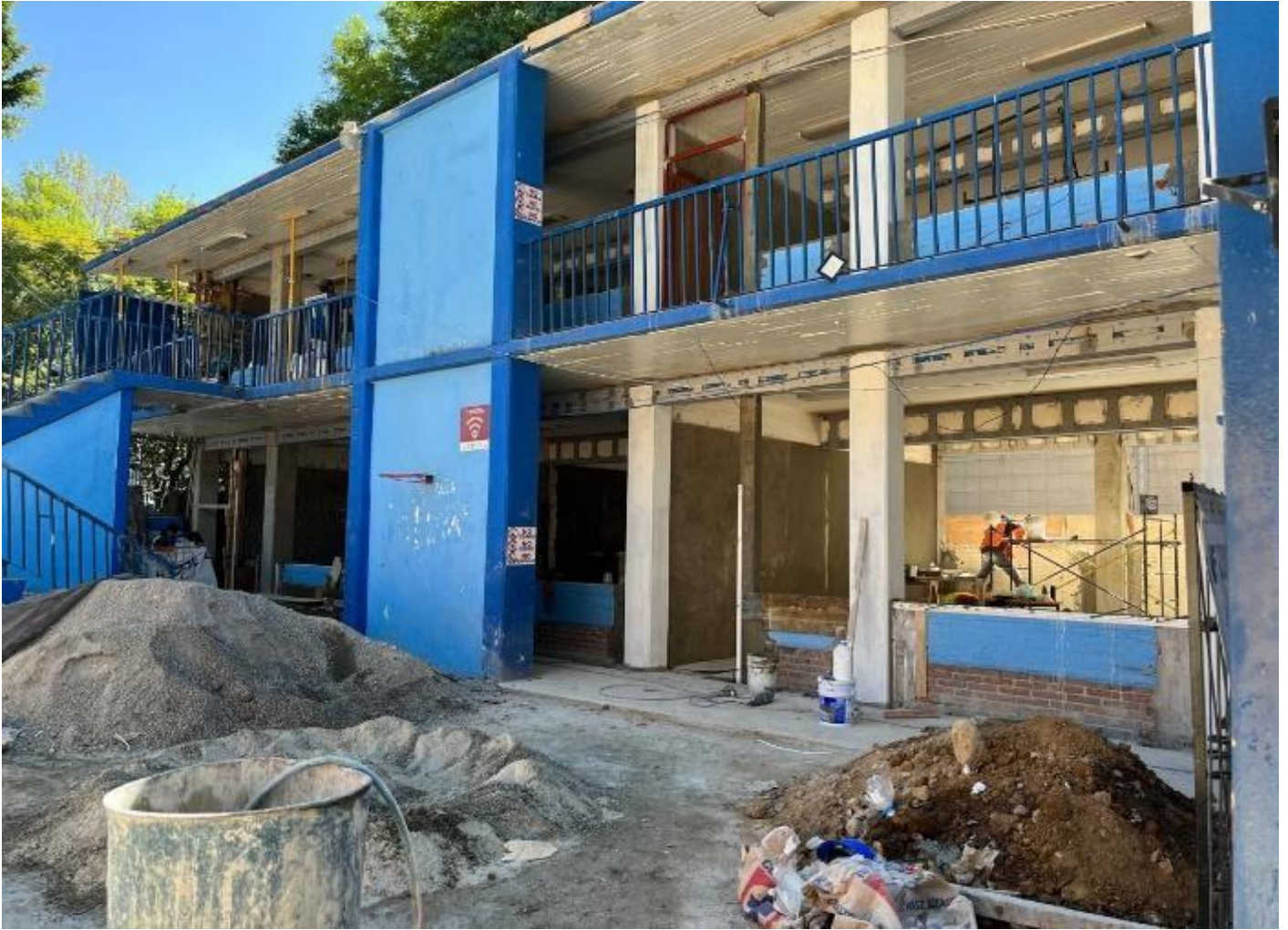
Ilustración 7 Reforzamiento, mantenimiento y rehabilitación en centro educativo nivel básico en centro educativo, Taxqueña
