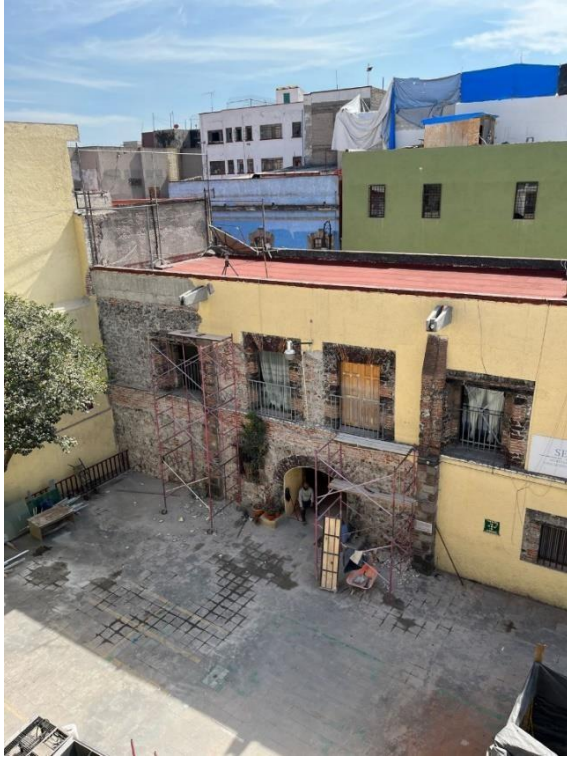
Ilustración 1 Rehabilitación de reforzamiento
