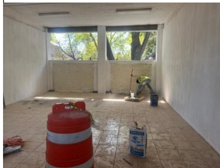
Ilustración 3 Reforzamiento y mantenimiento
