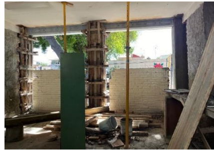
Ilustración 5 Trabajo en obra
