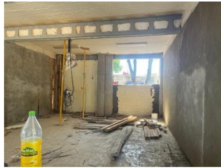
Ilustración 2 Reforzamiento estructural
