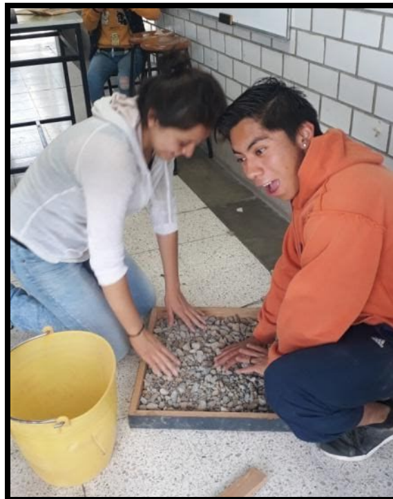
Imagen 9 "Preparación de la cama de grava"
