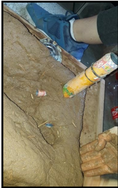
Imagen 26 "La cimbra de los tubos fue echa con latas recicladas"
