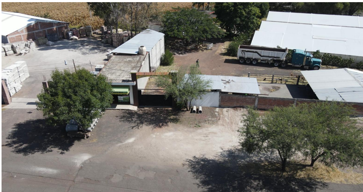
004 Equipo de reconocimiento de condiciones del terreno del Ingeniero, Archivo área VPyE.
