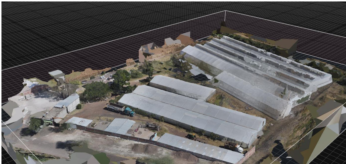
013 Fotogrametría de de condiciones del terreno del Ingeniero, Archivo área VPyE
