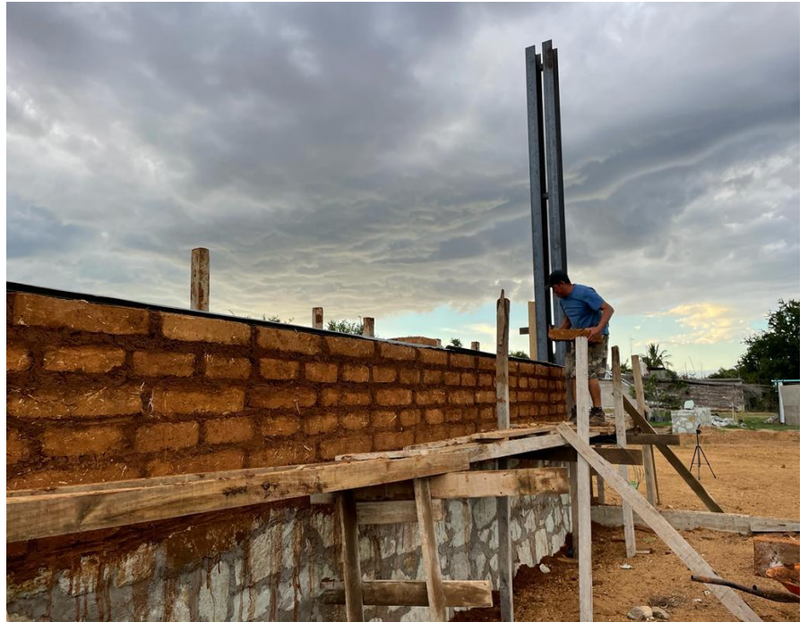
Imagen 12. Construcción de proyecto social, levantamiento de muros a base de adobe.
