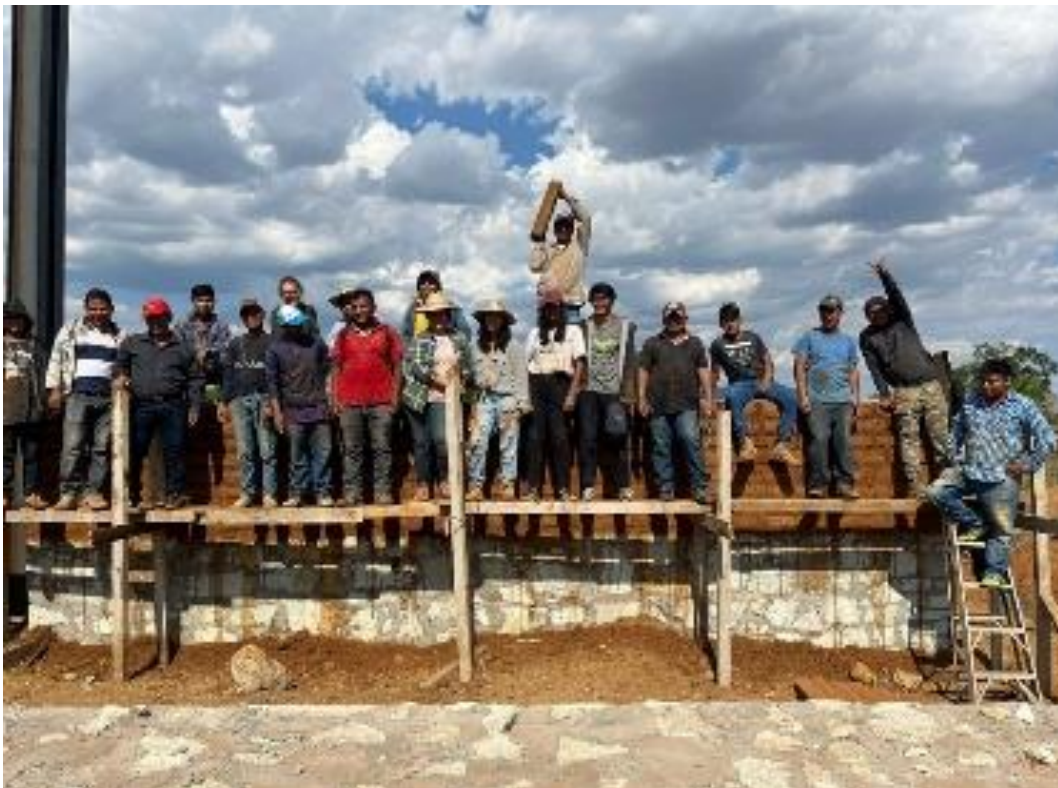
Imagen 13. Construcción de proyecto social, levantamiento de muros a base de adobe.
