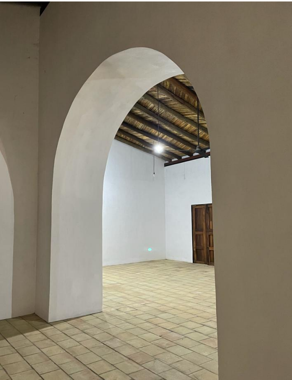
Imagen 19. Visita a Biblioteca Chiñas en la localidad de Juchitán de Zaragoza.
