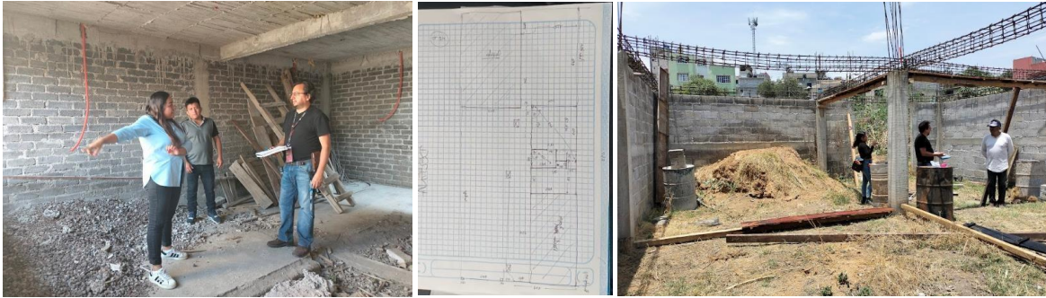
Imágenes # 1, 2 y 3 Visita inicial y levantamiento arquitectónico.
