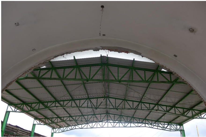
Imagen A.1 junta de cubierta de acero con la bóveda de cañón corrido
