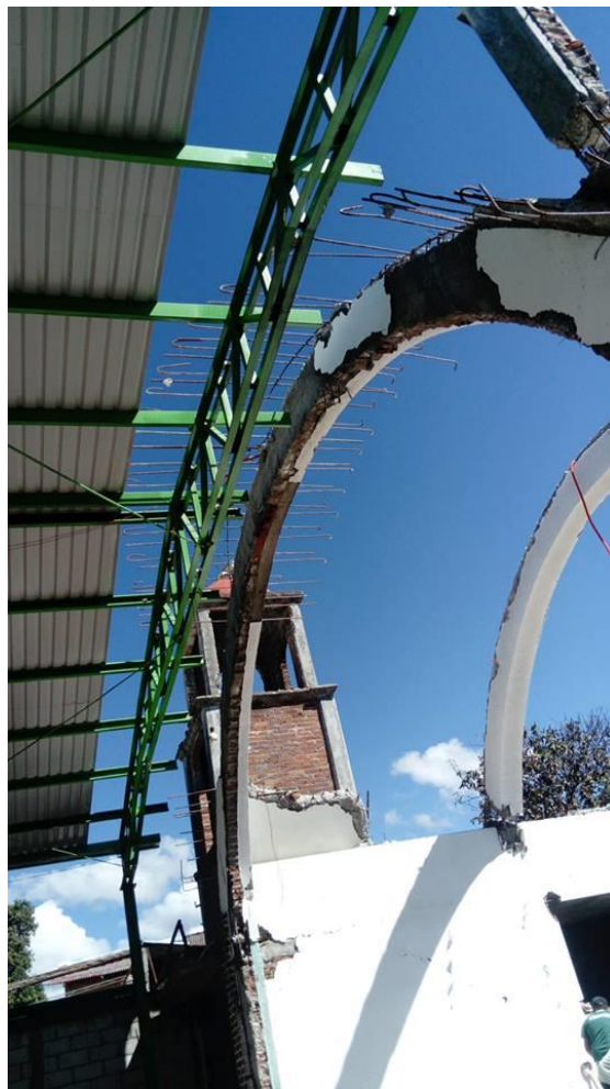
Imagen A.11 Demolición y retiro de escombros
