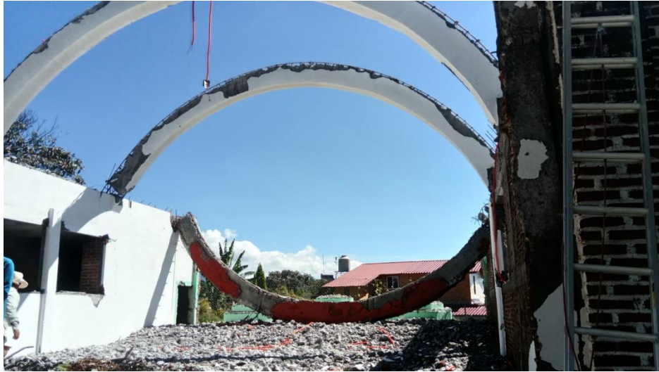
Imagen A.10 Demolición y retiro de escombros
