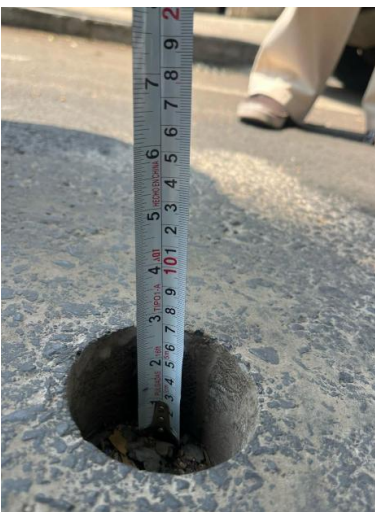
Foto 8. verificación de profundidad para pruebas de resistencia.
