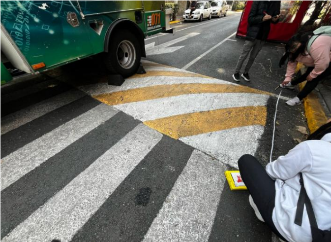
Foto 6. Levantamiento de balizamiento.
