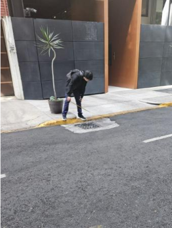
Foto 1. Supervisión de pavimentación.
