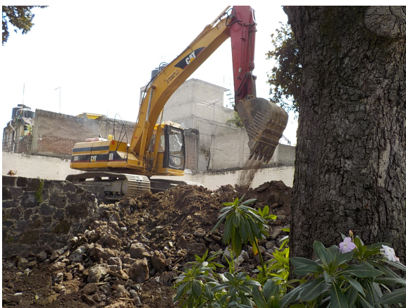
Acarreo de material, 320 CAT
