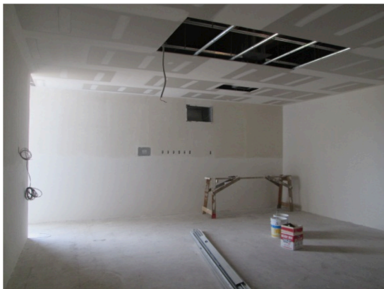
Proceso de obra Quirófanos
