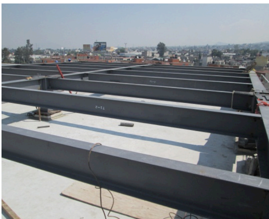
Estructura de helipuerto
