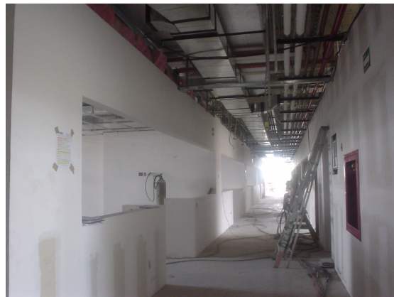
Proceso de obra
