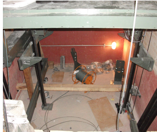
Anclaje de estructura de elevador
