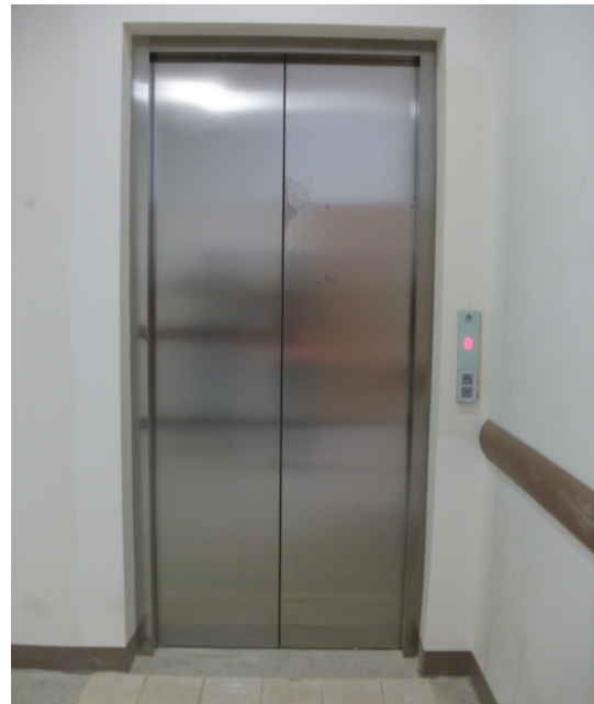
Conclusión de trabajos de elevador
