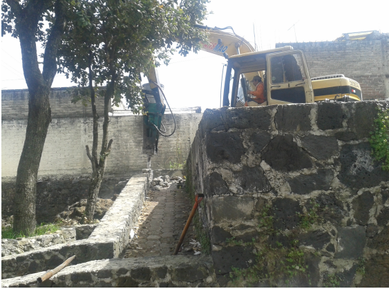
Demolición de rampa
