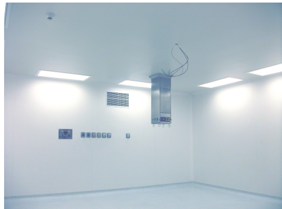
Conclusión de trabajos en quirófanos
