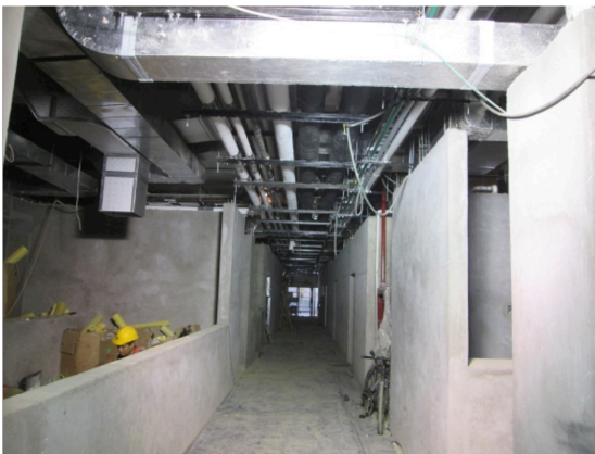
Proceso de obra
