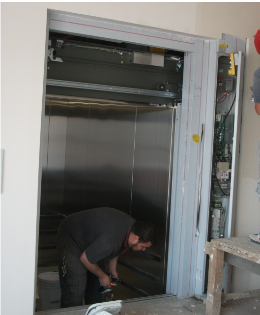
Instalación de elevador
