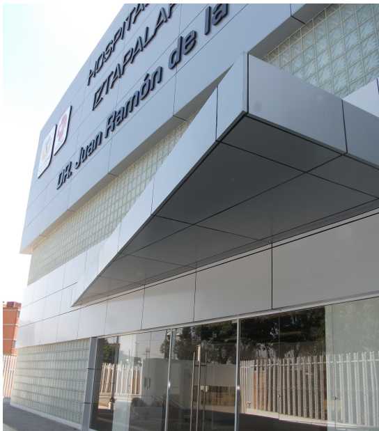
Conclusión de trabajos en Fachada
