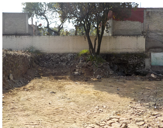
Conclusión de trabajos de demolición
