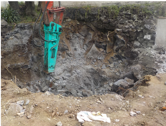
Excavación con una 320 CAT
