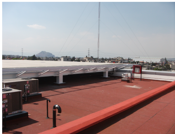
Conclusión de trabajos de helipuerto
