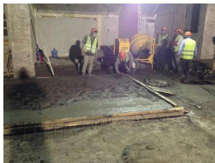
La taquilla se amplió, recorriendo el muro frontal, este se realizó en su totalidad de concreto armado, con varilla de acero corrugado, la parrilla se armó con acero del número 4 y estribos a cada 25 cm. y concreto pre mezclado directo en la cementera.
