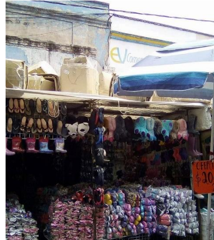
Ilustración 8 daño en colindancia por sismo
