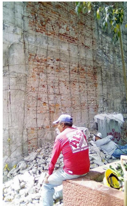
Ilustración 10 Reconstrucción y daños
