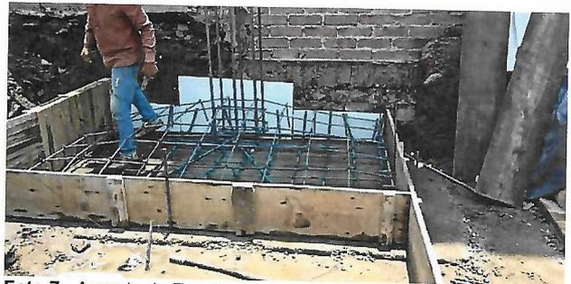
Foto 7.- Armado de Zapata de cimentación
