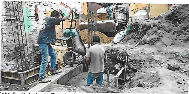
Foto 6.- Colado de Zapata de cimentación
