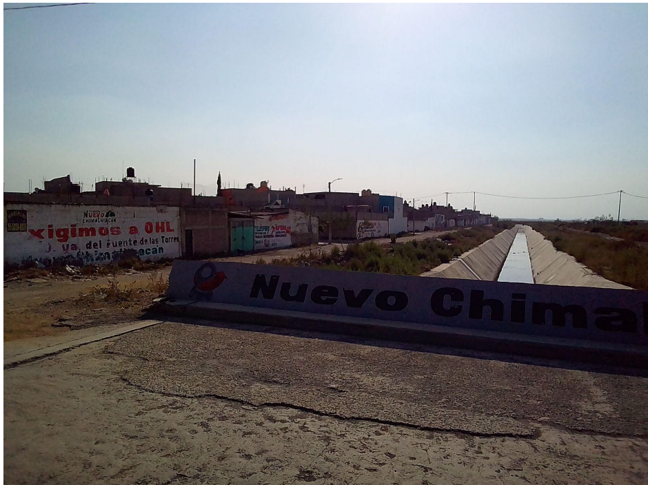
Frente al canal y sobre el puente de acceso a Tlatel Xochitenco, Chimalhuacán.
