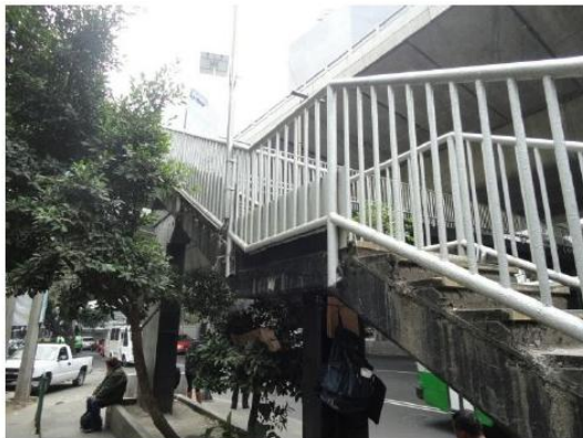
Puente Peatonal Periférico Norte y Calle Horacio
