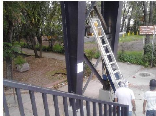
Puente Peatonal Canal de Miramontes y Fortín
