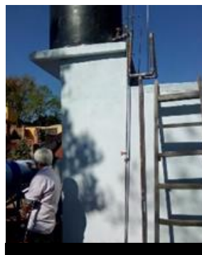
Imagen 05: visita de supervisión de instalaciones
