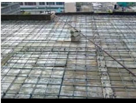
Imagen 04: supervisión de armado de losa en primer nivel.
