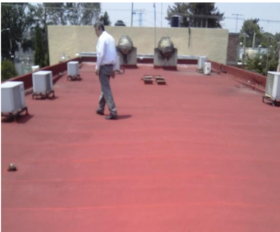
Proceso de levantamiento arquitectónico.
