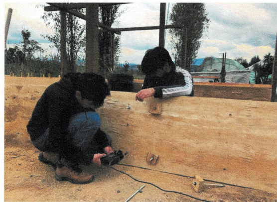
Fotografía 7 Instalación del encofrado para Tapial, foto tomada por el Mtro. Fernando Roberto Chiapa Sánchez, 2024
