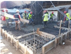
Foto10: Colado de cimentación
