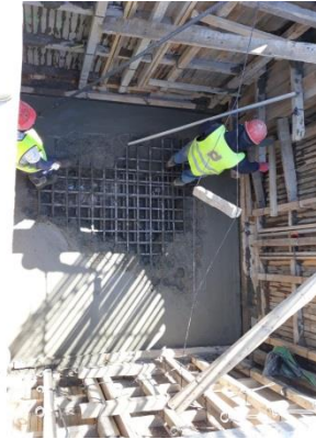
Foto9: Colado de cimentación
