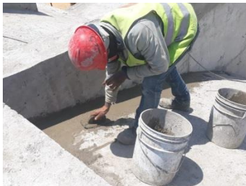
Foto19: Resanes en losa
