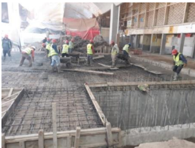
Foto 1: Cimbrado de losa tapa de cisterna
