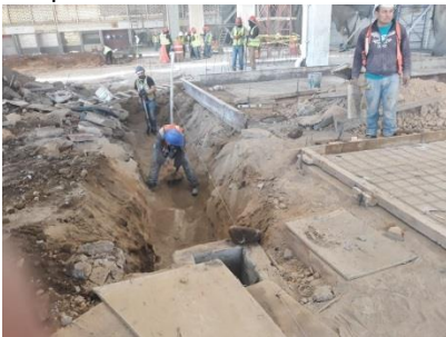
Foto 2: Zanjas y colocación de registros
