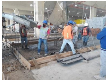
Foto5: Colado de una de las islas
