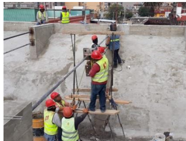
Foto20: Colocación de tensores
