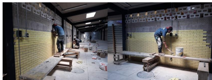
Foto8: Colocación de fachaleta en muros interiores
