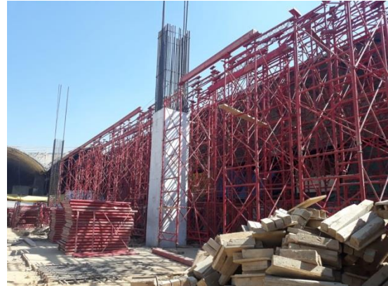
Foto14: Colocación de andamios para losa
