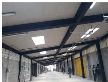
Foto7: Zona del Banquetón, colocación de inst. Eléctrica
