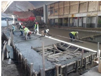
Foto 3: Colado de losa tapa
