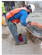
Foto11: Prueba de revenimiento
