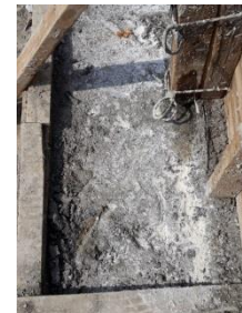
Foto: 21: Detalle en losa
