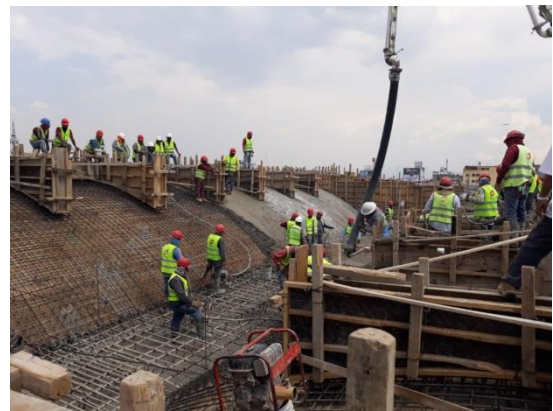
Foto15: Colado de losa con bomba de pluma
