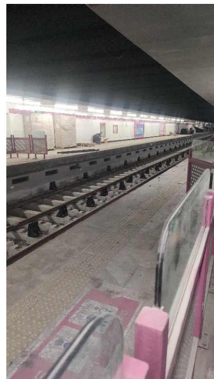
Ilustración 11. Instalación de vías nuevas. Estación Cuauhtémoc
