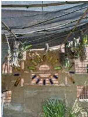
Figura 8. Intervención de restauración en el huerto de orquídeas: Aplicación de mortero o consolidante a base de cal apagada y aditivo orgánico de mucílago (baba) de nopal para la conservación del elemento
