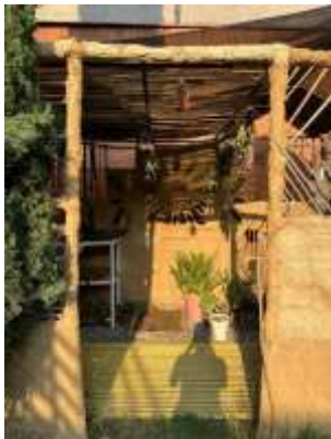
Figura 8. Intervención de restauración en el huerto de orquídeas: Aplicación de mortero o consolidante a base de cal apagada y aditivo orgánico de mucílago (baba) de nopal para la conservación del elemento
