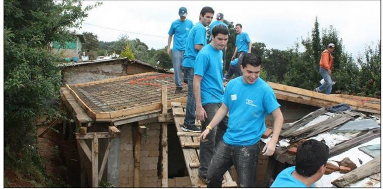
Boteo de concreto para colado de losa
