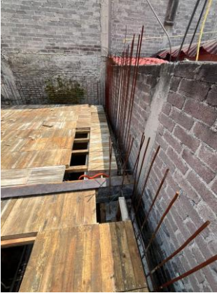
Foto 1.1 Vista del sistema de cimbrado de madera instalado para la losa
