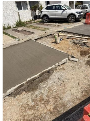
Foto 9.2 Vista general de la superficie recién intervenida
