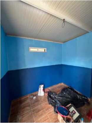
Foto 4.1 Vista interior de la caseta con trabajos de acabados terminados
