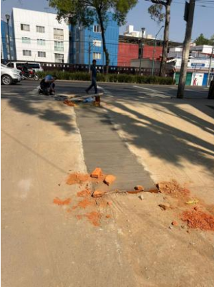
Foto 6.4 Detalle del área intervenida con la reposición de pavimento
