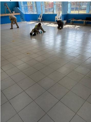
Foto 4.4 Limpieza de piso ya instalado
