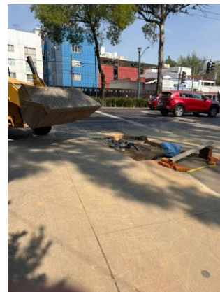
Foto 6.3 Vista del área de trabajo
