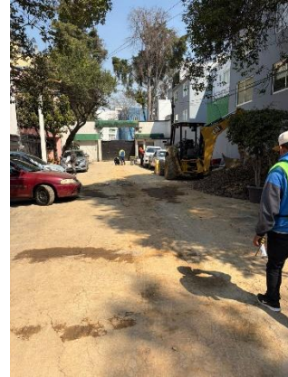
Foto 6.6 Comprobando el avance de los trabajos
