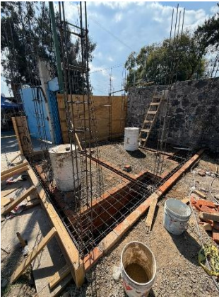
Foto 8.1 Vista del armado de cimentación en etapa inicial
