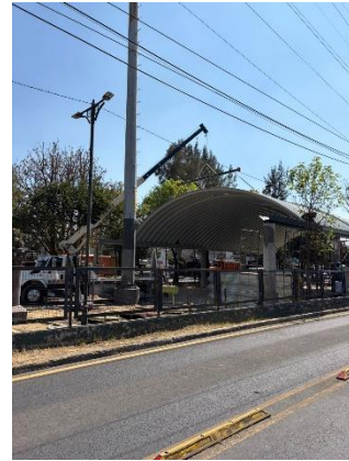
Foto 7.3 Vista exterior de la cubierta tipo arco verificando su correcta integración
