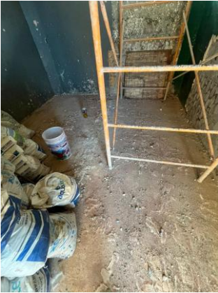
Foto 2.1 Vista interior del espacio durante la etapa de intervención
