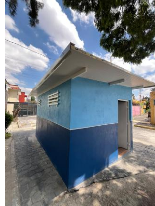
Foto 4.3 Vista exterior lateral de la caseta una vez concluidos los trabajos
