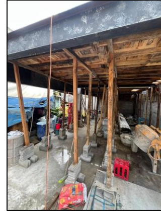
Foto 1.3 Vista interior del sistema de apuntalamiento
