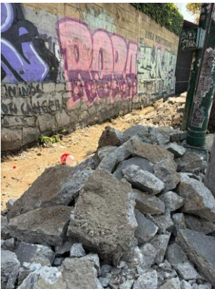
Foto 5.1 Detalle del material de de la demolición de la banqueta existente
