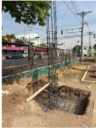
Foto 7.2 Supervisión del armado de zapata para la cimentación de los apoyos de la cubierta
