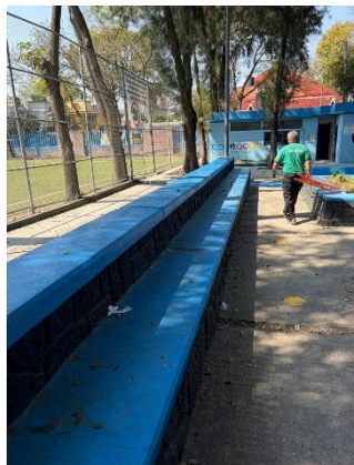
Foto 3.5 Vista exterior de las gradas del deportivo con los trabajos de pintura
