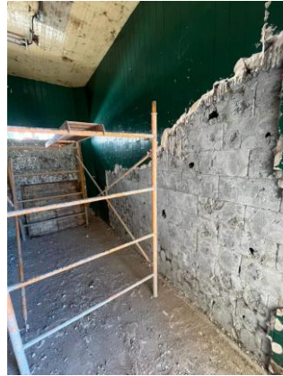
Foto 2.2 Detalle del estado de los muros durante el proceso de rehabilitación
