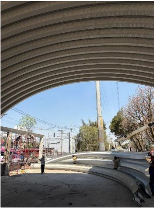
Foto 7.1 Vista interior de la estructura de arco metálico durante su instalación
