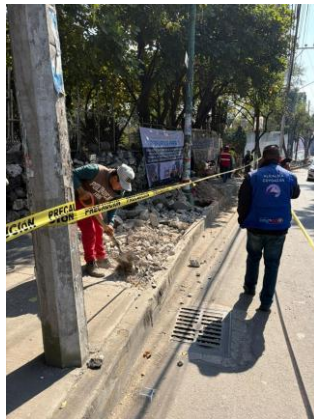
Foto 5.2 Supervisión del proceso de demolición
