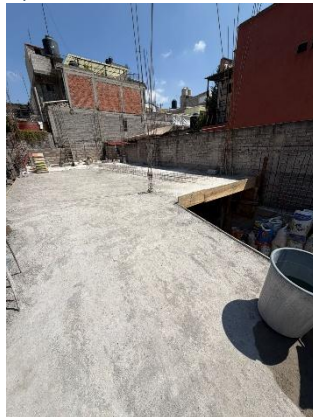
Foto 1.5 Vista cenital de la losa terminada, comprobando la uniformidad del colado
