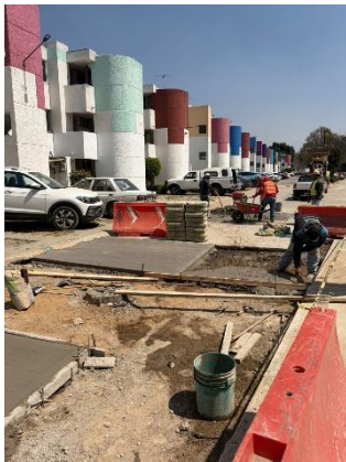
Foto 9.1 Supervisión del proceso de colocación de carpeta de la calle
