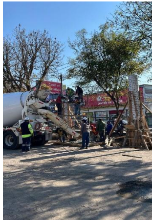
Foto 7.4 Supervisión del proceso de colado de la cimentación
