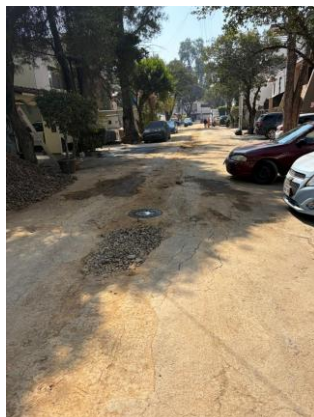
Foto 6.2 Vista general de la zanja abierta a lo largo de la calle
