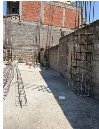
Foto 1.6 Vista lateral de la losa con estructura de muros perimetrales
