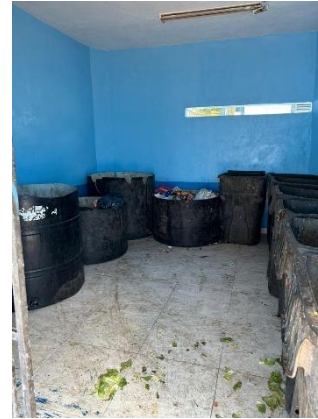
Foto 2.3 Vista general del espacio una vez concluidos los trabajos de rehabilitación
