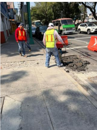
Foto 6.1 Supervisión del inicio de excavación en calle con personal técnico en sitio
