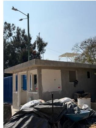
Foto 8.3 Vista general de la caseta en etapa avanzada de la construcción
