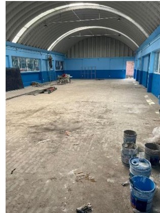
Foto 3.3 Vista general del interior de la nave principal con el piso retirado
