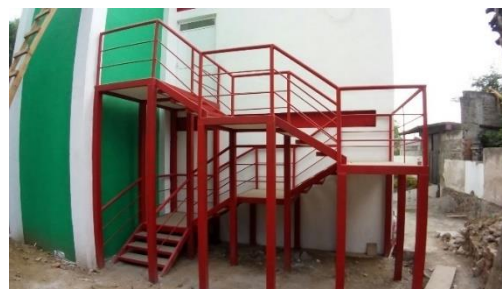
Ilustración 10 Escaleras de emergencia
