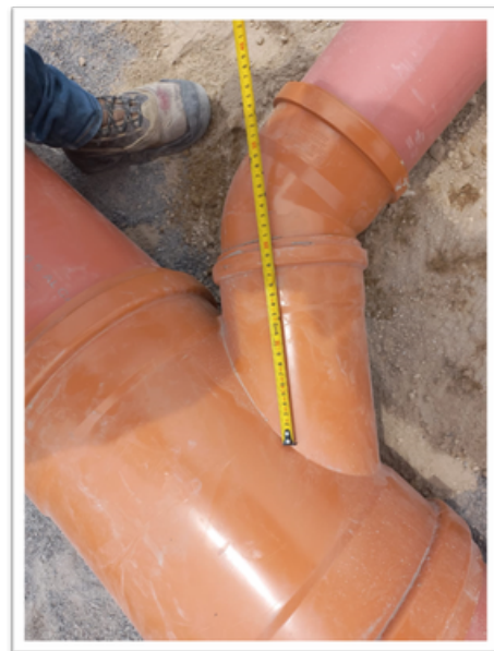
Correa Tovias, C. (2023). Medición de la pieza para realizar el detalle [Foto 9].
