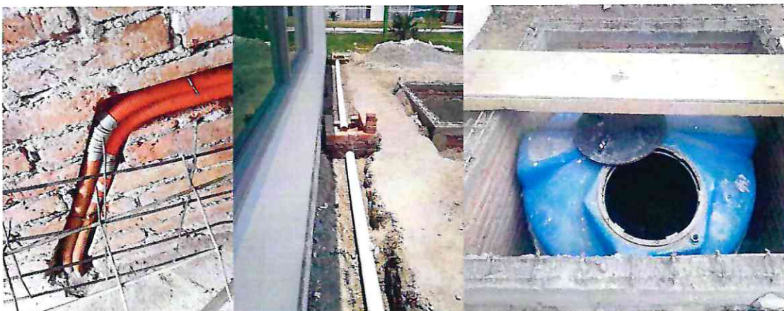
Foto 6, 7, 8, colocación de componentes de instalaciones
