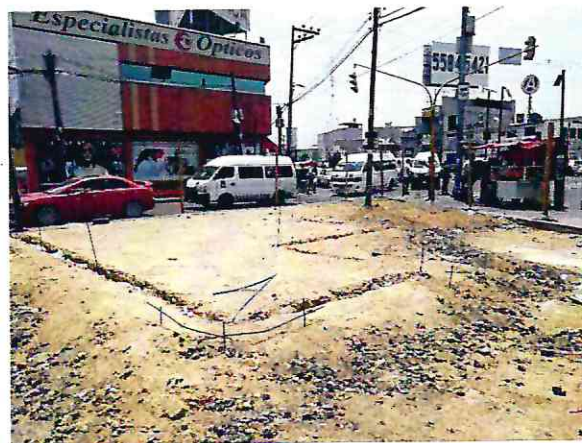
Foto 2. Trazo para desplante de construcción
