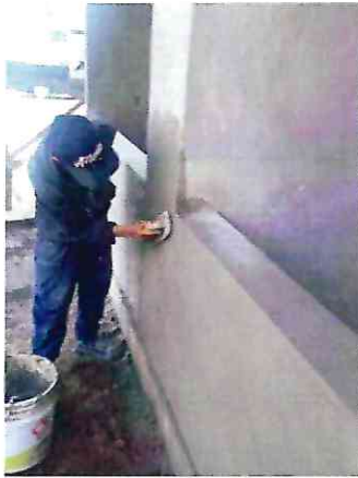
Foto 9, 10 colocación de aplanados en muros y plafones Fuente: Cervantes 2019
