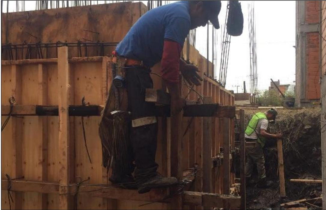
**Foto 14. Colocación de cimbra en cajón de cimentación.**
