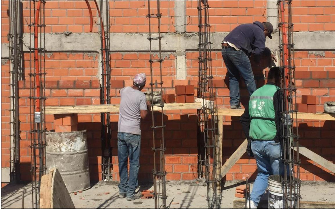
**Foto 22. Enrase de muros del segundo nivel.**
