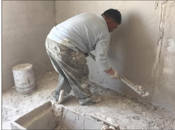
**Foto 3. Colocación de yeso en muros**
