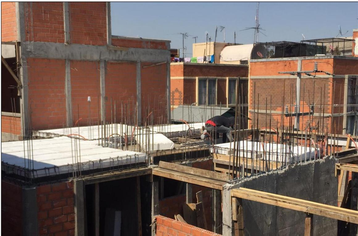
**Foto 23. Colocación de vigueta y bovedilla de losa del segundo nivel.**
