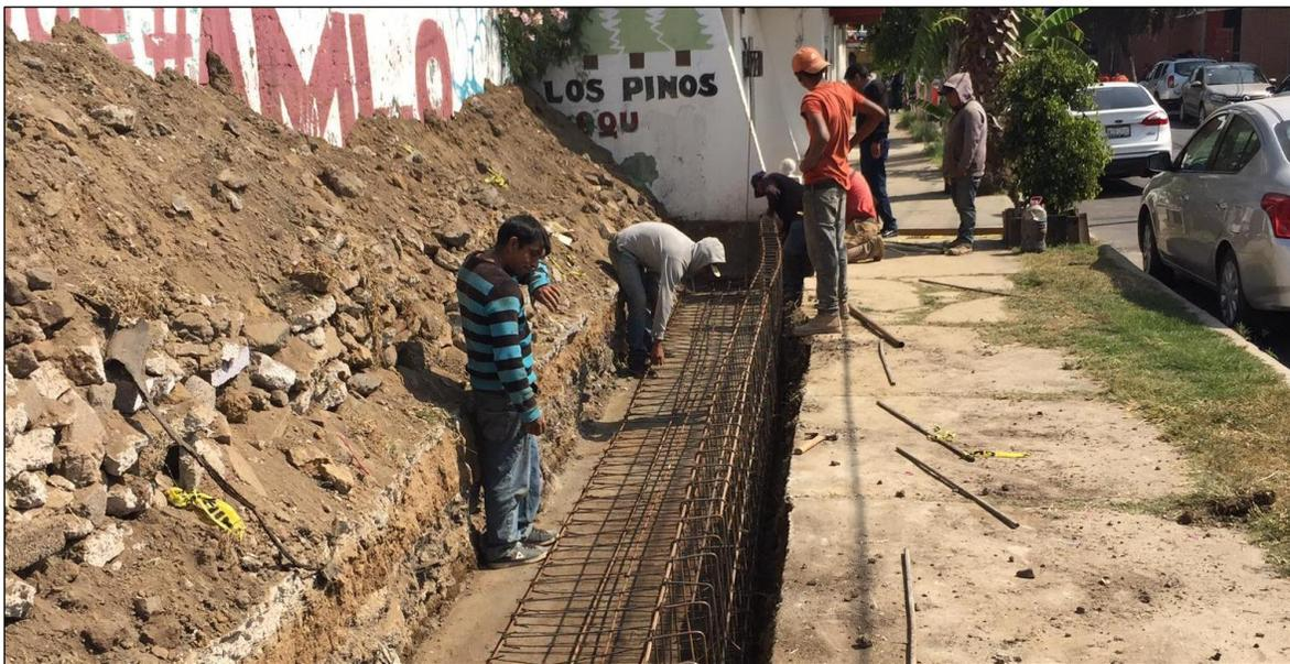
**Foto 5. Montaje del armado de la zapata perimetral**
