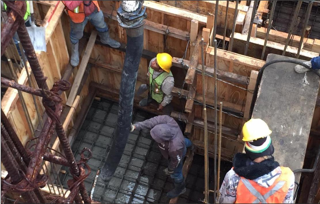
**Foto 16. Colado de losa de fondo del cajón de cimentación.**
