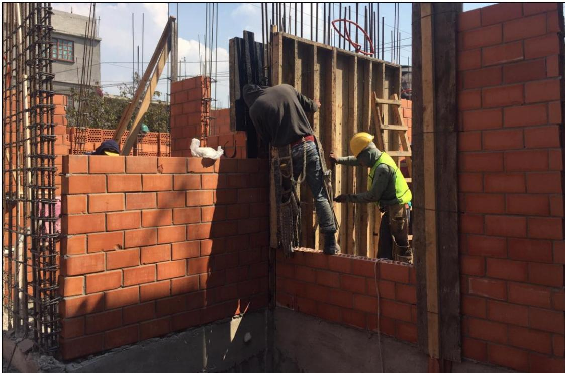
**Foto 19. Enrase de muros y colocación de cimbra en muros de concreto en planta baja.**
