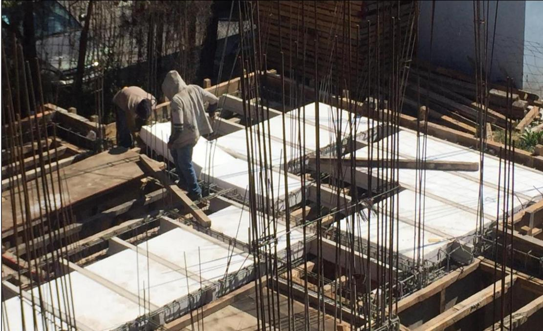
**Foto 18. Colocación de vigueta y bovedilla de la losa tapa del cajón de cimentación.**
