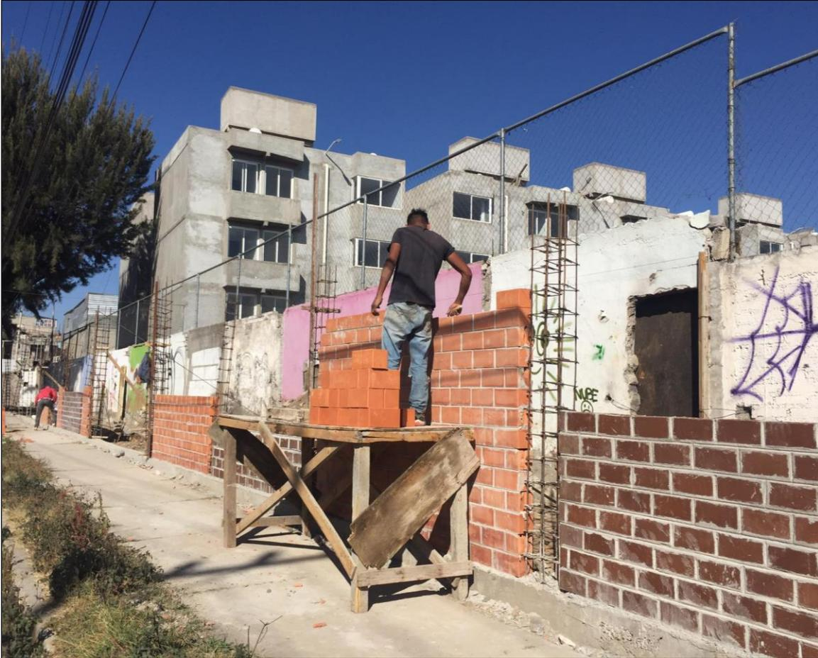
**Foto 6. Enrase de muros en la barda perimetral.**
