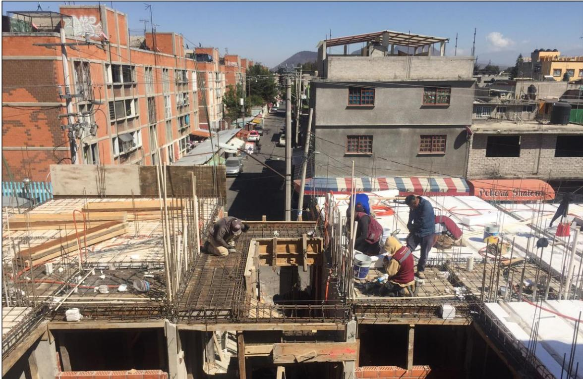
**Foto 21. Colocación de vigueta y bovedilla en losa del primer nivel.**
