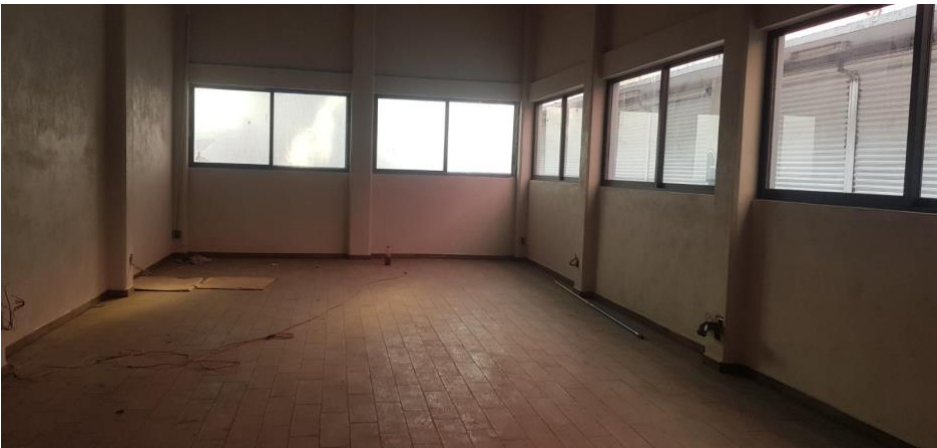
Foto 2. Salon a doble altura (colocación de ventanas)
