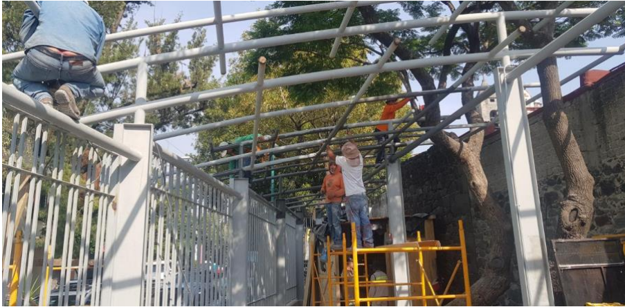
Foto 4. Instalación de velaría
