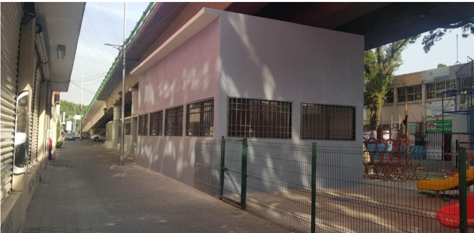
Foto 3. Vista exterior norte del salón de usos múltiple
