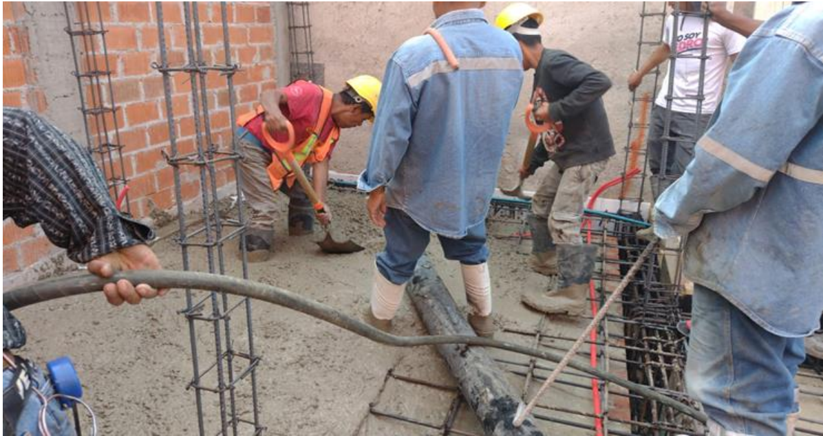
Imagen 18. Registro de visita: Se realizan trabajos durante el colado de la cimentación.
