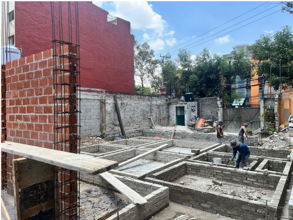
Imagen 20. Registro de visita: Se inician con trabajos de cimentación para el tercer núcleo de departamentos, con el desplante de los muros de los cajones.
