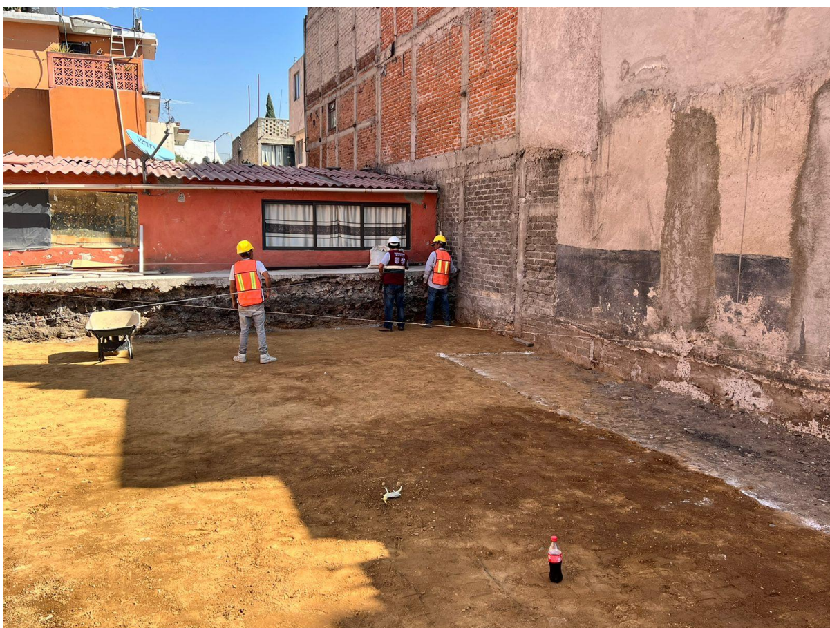
Imagen 4. Registro de visita: trazo y niveles del terreno.
