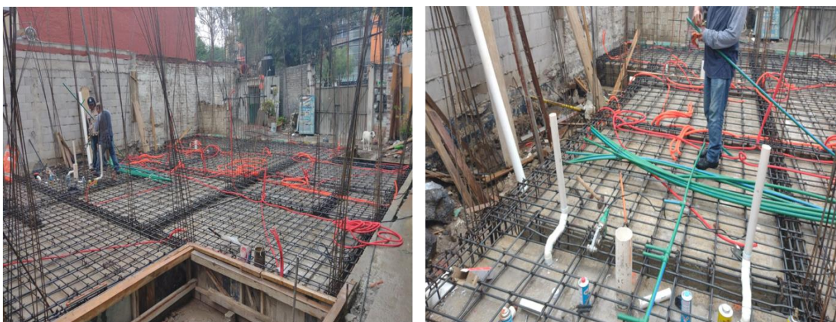
Imagen 21. Registro de visita: Se percibe el armado estructural de la cimentación, dejando ver la preparación de las instalaciones eléctricas, hidráulicas y sanitarias correspondientes.
