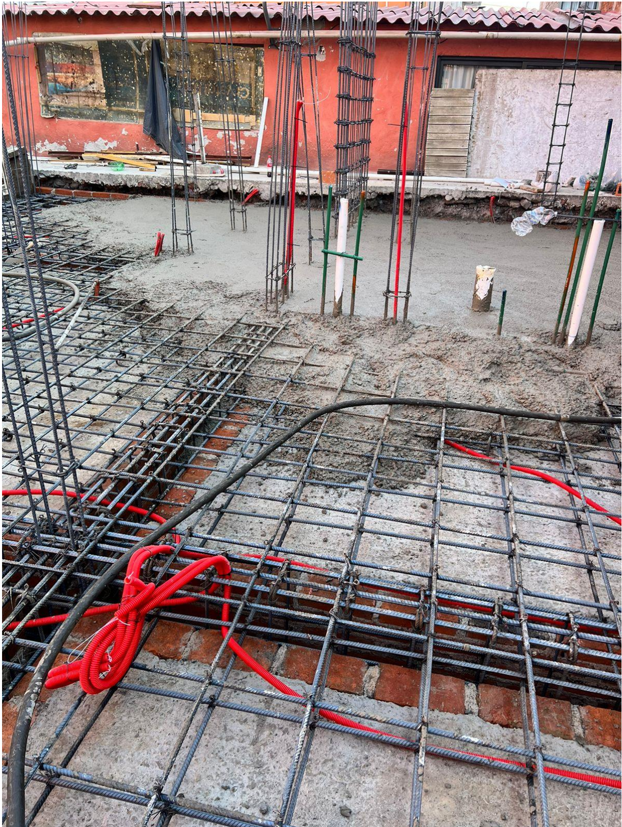
Imagen 8. Registro de visita: se realizó el colado de la cimentación, se puede ver el armado estructural de la misma, así como las salidas de la instalación eléctrica, hidráulica y sanitaria.
