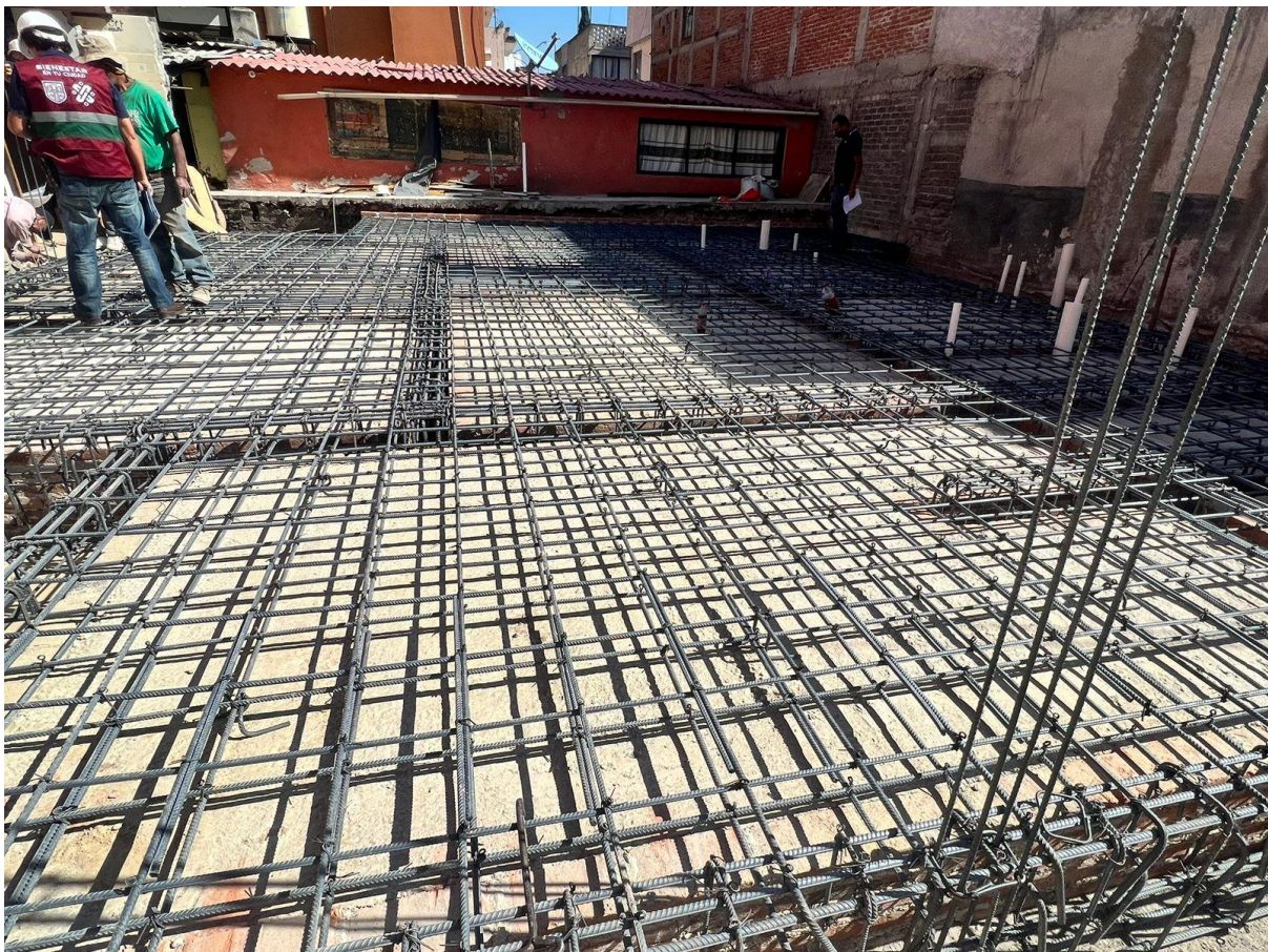
Imagen 17. Registro de visita: Se revisa el armado estructural de la cimentación previo al colado de la masa, de igual forma se percibe las salidas de la instalación sanitaria.
