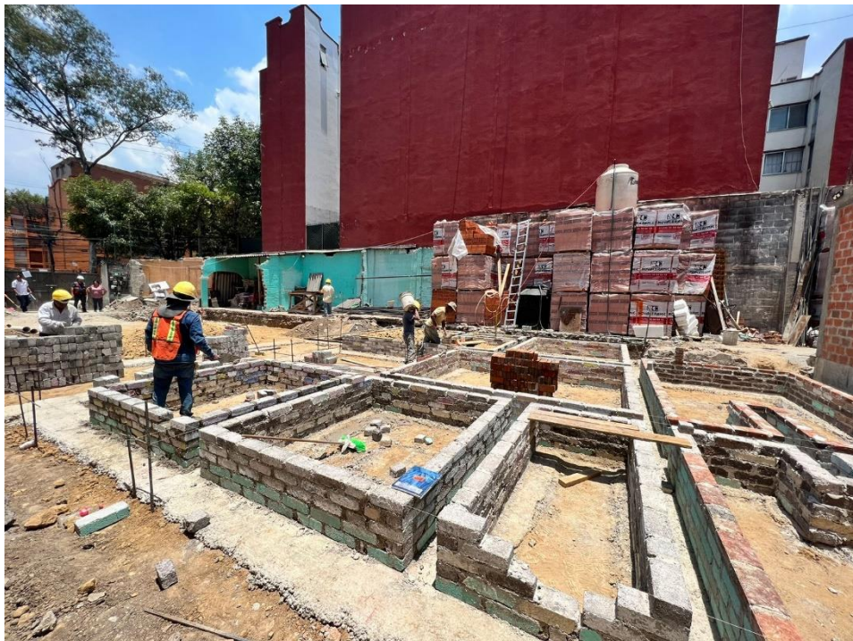
Imagen 15. Registro de visita: Se percibe la realización de los cajones de cimentación del segundo núcleo de departamentos.
