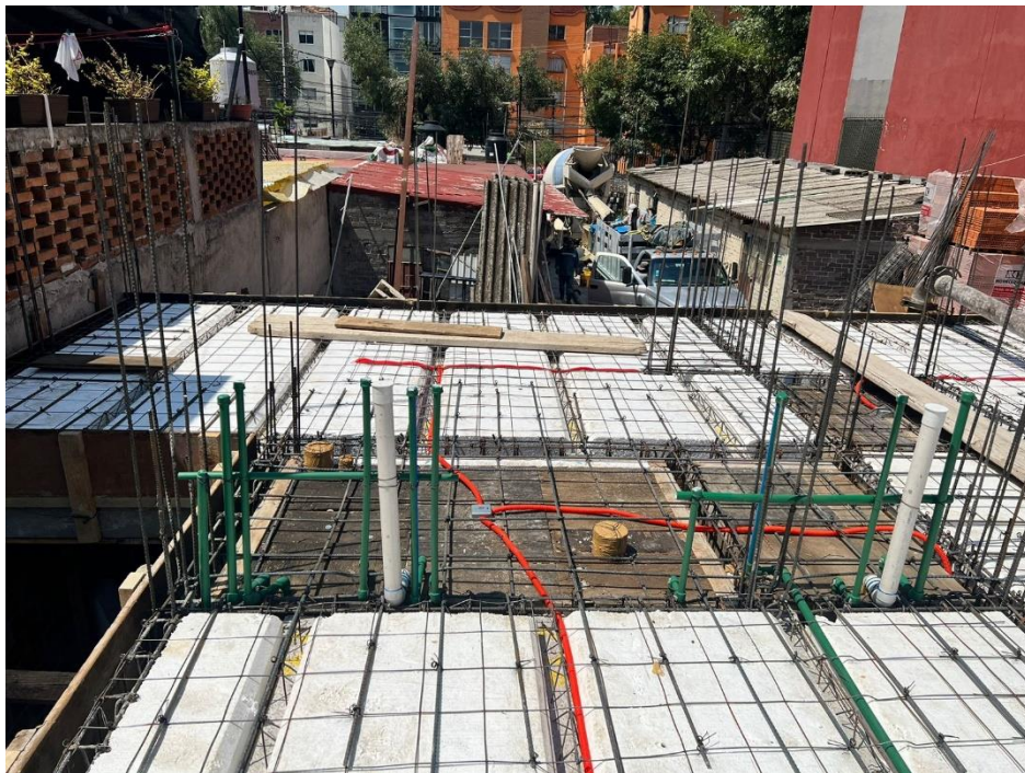
Imagen 12. Registro de visita: Se colocó el sistema de entepiso siendo vigueta y bovedilla, en donde se percibe de igual forma las instalaciones eléctricas, hidráulicas y sanitarias.
