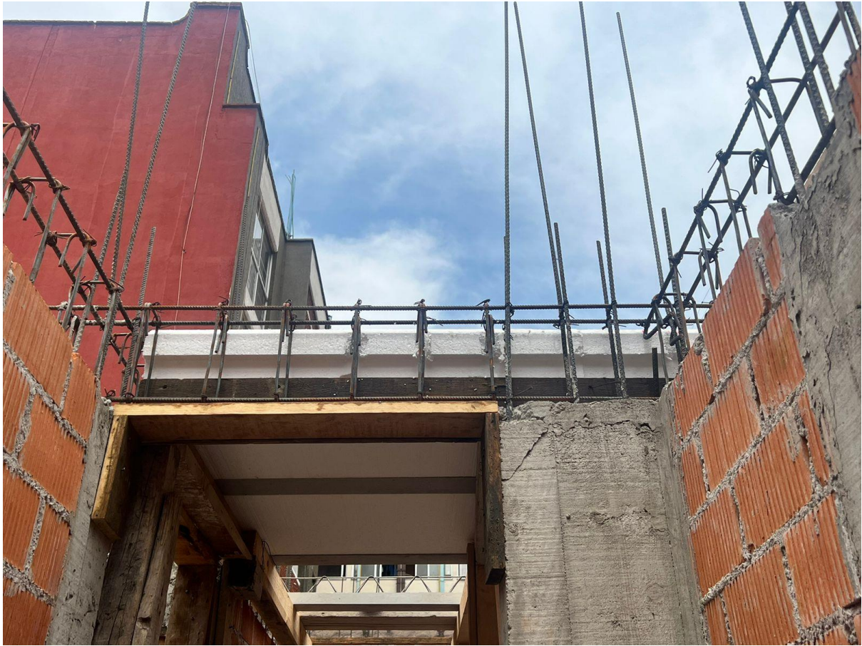
Imagen 11. Registro de visita: Armado de las trabes
