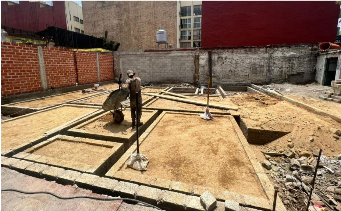
Imagen 16. Registro de visita: Relleno de los cajones con tepetate, compactado en dos capas.
