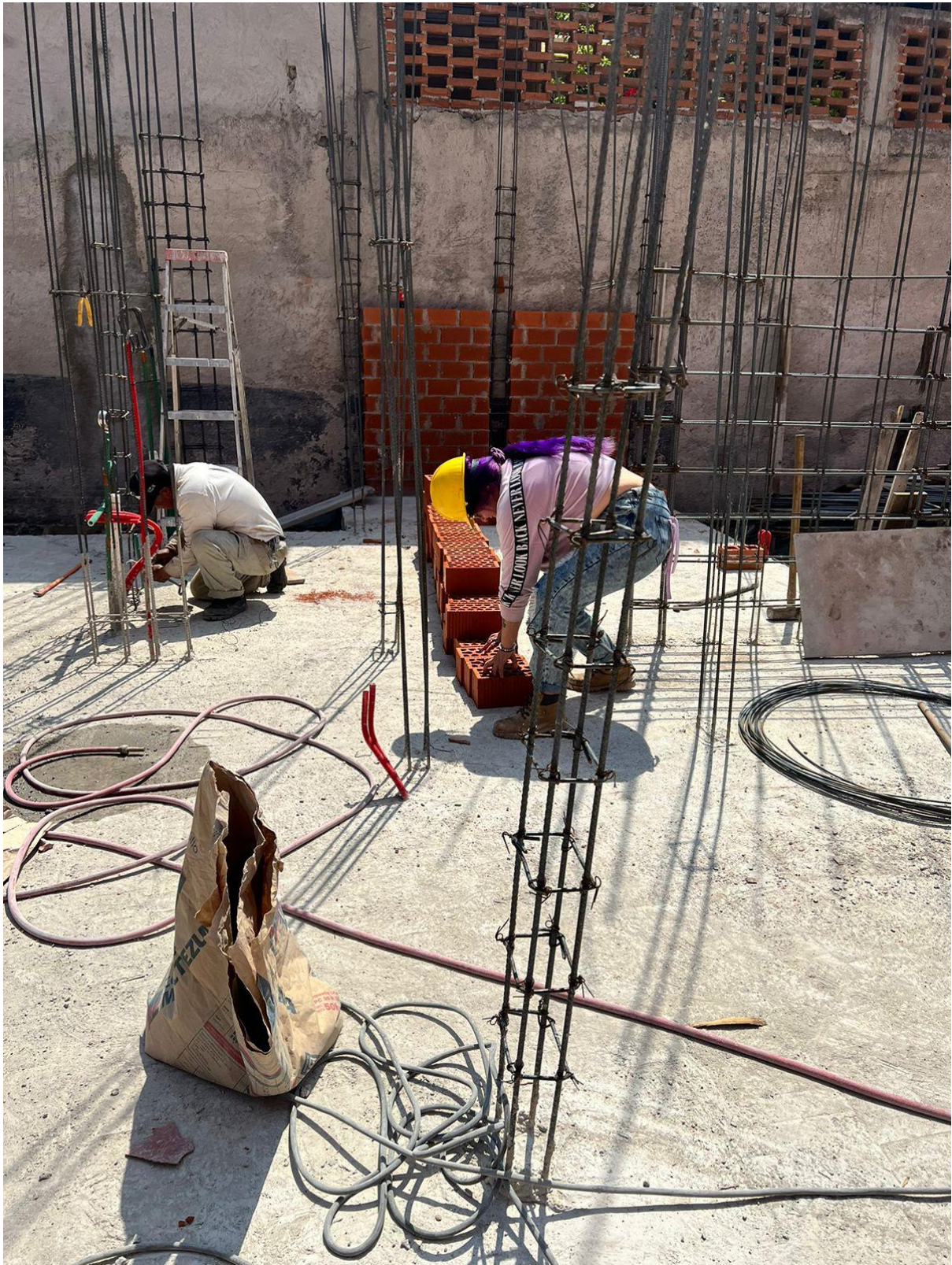
Imagen 9. Registro de visita: se procedió a realizar el armado de los castillos.
