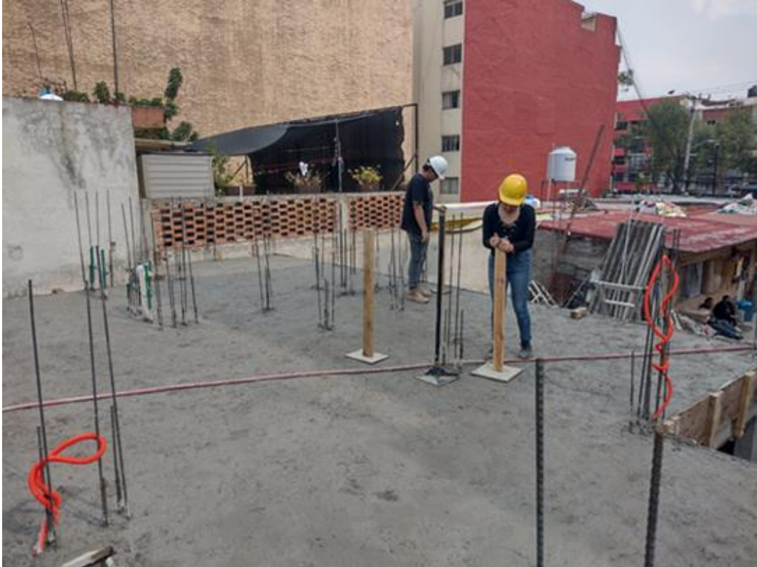
Imagen 14. Registro de visita: Colado de losa de primer nivel.
