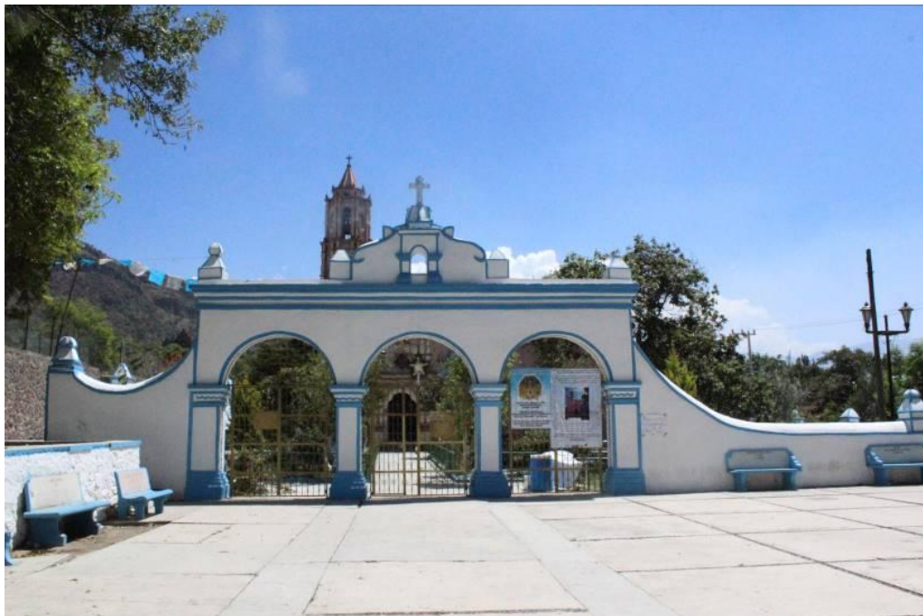
ARCOS DE ACCESO PRINCIPAL AL TEMPLO
