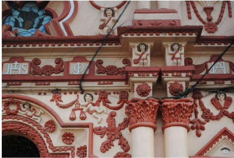
ORNAMENTACIÓN DE FACHADA PRINCIPAL HECHA DE AGAMASA
