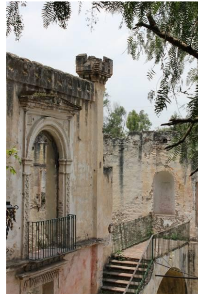
CASA PRINCIPAL, ESCALINATA QUE CONECTABA HACIA LAS RECÁMARAS DESDE EL GRAN SALÓN
