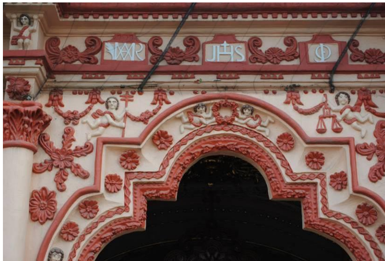
ORNAMENTACIÓN DE FACHADA PRINCIPAL HECHA DE AGAMASA
