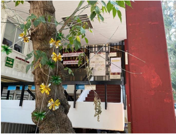
a) Fachada principal Fuente: Archivo fotográfico del prestador (2026).
