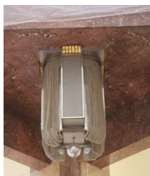
Evidencia de daños en lámparas
