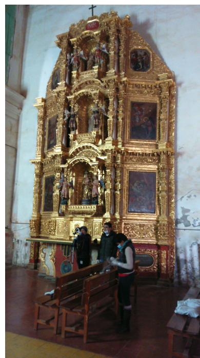
Imagen 7 Detección de daños y deterioros. Templo de San Juan Tabaá. Credits: Rodrigo Labastida Trejo
