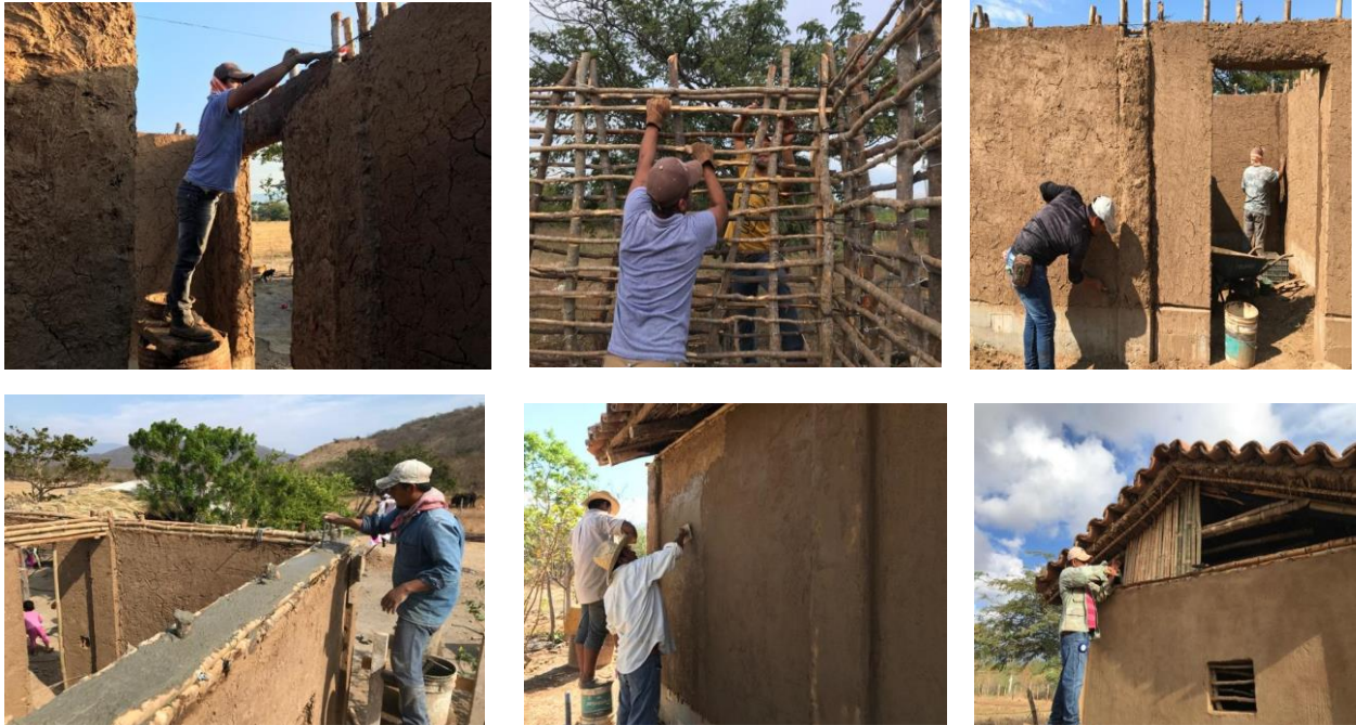
Figura 21. Fotografías tomadas la colocación de muros de tepetate de viviendas en Santo Domingo, Oaxaca, imágenes tomadas por : Zaldívar Lizet , 16/11/2022.
