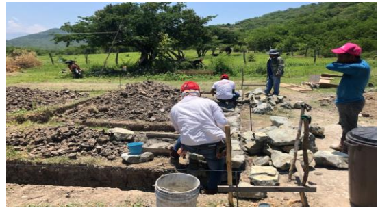
Figura 19. Fotografías tomadas la cimentación de viviendas en Santo Domingo, Oaxaca, imágenes tomadas por : Zaldívar Lizet , 16/11/2022.
