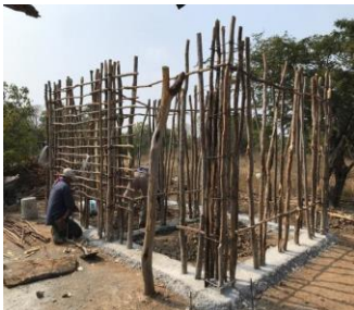
Figura 20. Fotografías tomadas la colocación de muros de viviendas en Santo Domingo, Oaxaca, imágenes tomadas por : Zaldívar Lizet , 16/11/2022.
