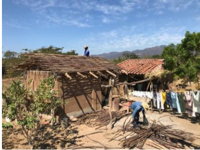
Figura 22. Fotografías tomadas la colocación de techos de tepetate de viviendas en Santo Domingo, Oaxaca, imágenes tomadas por : Zaldívar Lizet , 16/11/2022.
