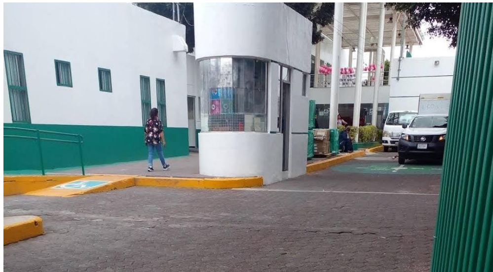
Figura 2. Entrada del centro de salud
