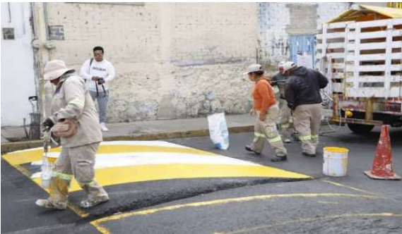
Balizamiento en vialidades primarias y secundarias.
