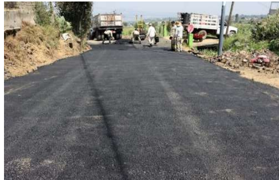
Compactación de asfalto para encarpetado.
