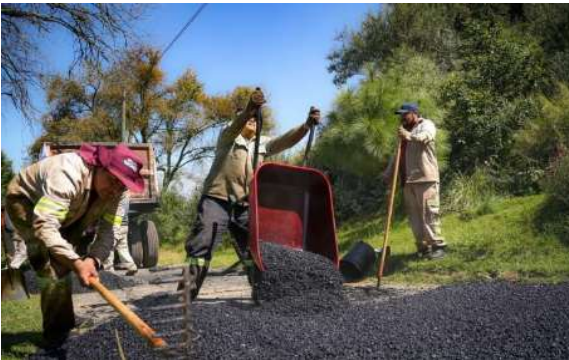
Tendido de asfalto.
