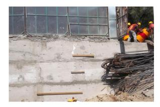
\*En esta imagen podemos apreciar los muros de contención los cuales fueron colocados para soportar los empujes de la tierra y fueron hechos a base de concreto armado.
