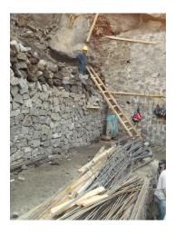
\*Muros de contención construidos provisionalmente con la piedra extraída del sito de excavación y material retirado manual mente.
