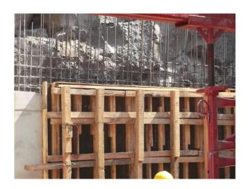
\*En la foto se muestra el trabajo de colado de un muro de contención el cual está del lado de una construcción aledaña, también se puede apreciar el armado de columnas.
