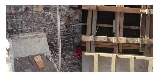
Foto tomada en una de las esquinas del terreno donde se puede notar las varillas que se utilizaron para el armado, en la otra podemos notar todavía como se colocó la cimbra para el colado la cual está sujeta con alambren del cual desconocemos el calibre de este, en algunas partes la cimbra no se pudo recuperar ya que quedo del lado que esta continuo al terrenos aledaños y por lo cual es muy difícil retirar la cimbra de madera.
