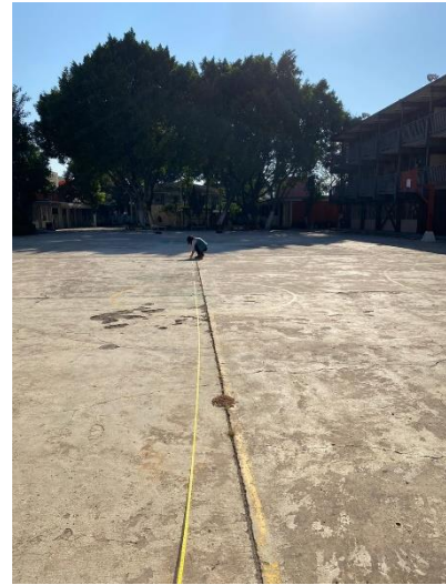
Fotografía 2._ Levantamiento del patio Fuente: Propia, 2020
