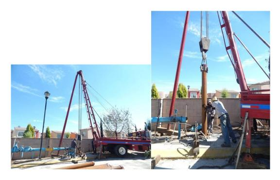
Una vez que la perforación quedo entran el área de obra civil para colocar la delimitante y apoyos para la tubería
