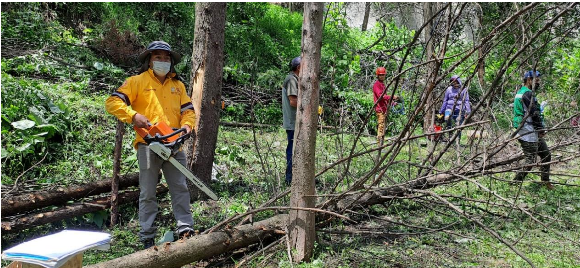
Figura 7. Trabajos de poda y derribo en Barranca Mixcoac.
